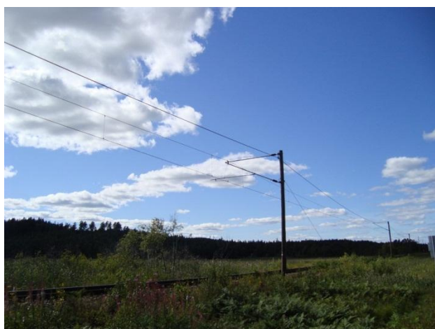
Befintlig järnväg mellan Ed och Bäckefors.
